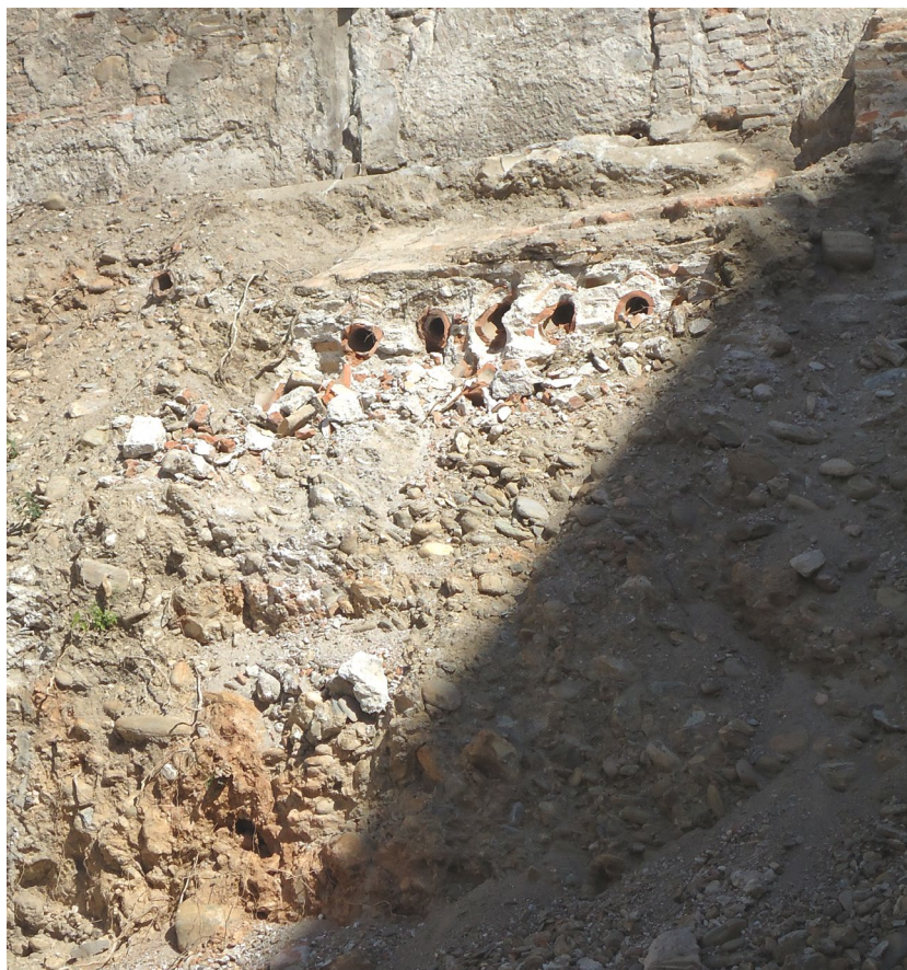
Figura 2 – Tuberías de cerámica bajo la rampa UE 2.
