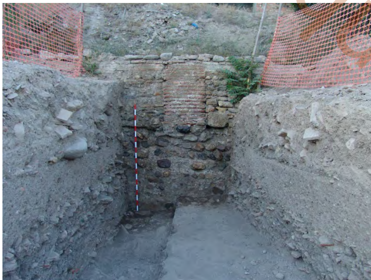
Alzado del sondeo 2 en el que se localiza la muralla en el nivel inferior, hasta 0,50 mt desde el nivel de suelo de la excavación. El resto del alzado corresponde a un muro de aterrazamiento y contención del nivel superior de factura moderna contemporánea.
