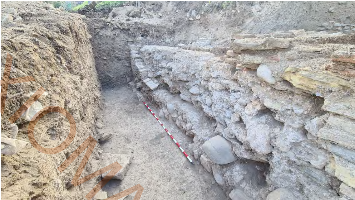
Fig 27 –Cara extramuros del lienzo interno con el muro de refuerzo que le adosan en el siglo XIX.
