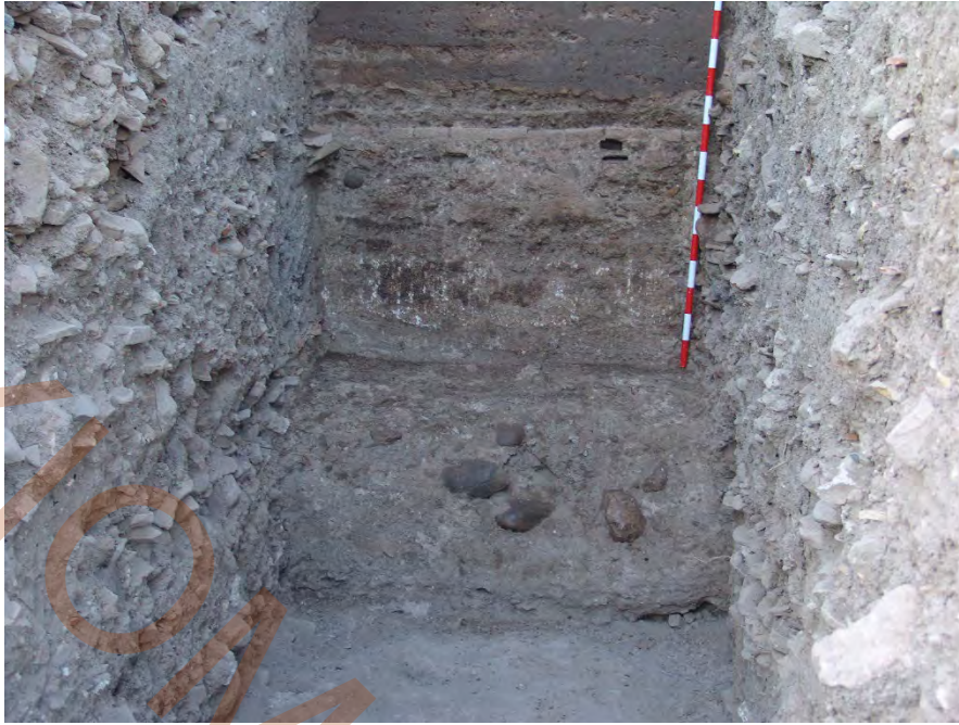
3 Fig. 64 – Zarpa de cimentación del torreón
