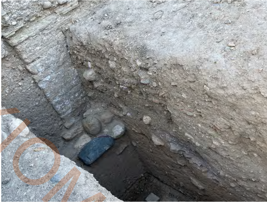
4 Fig. 65 – Zarpa de cimentación del torreón
