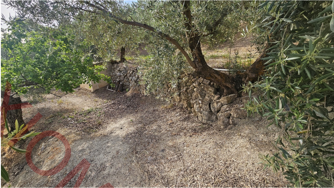
Parata de mampuestos de roca caliza del terreno.
